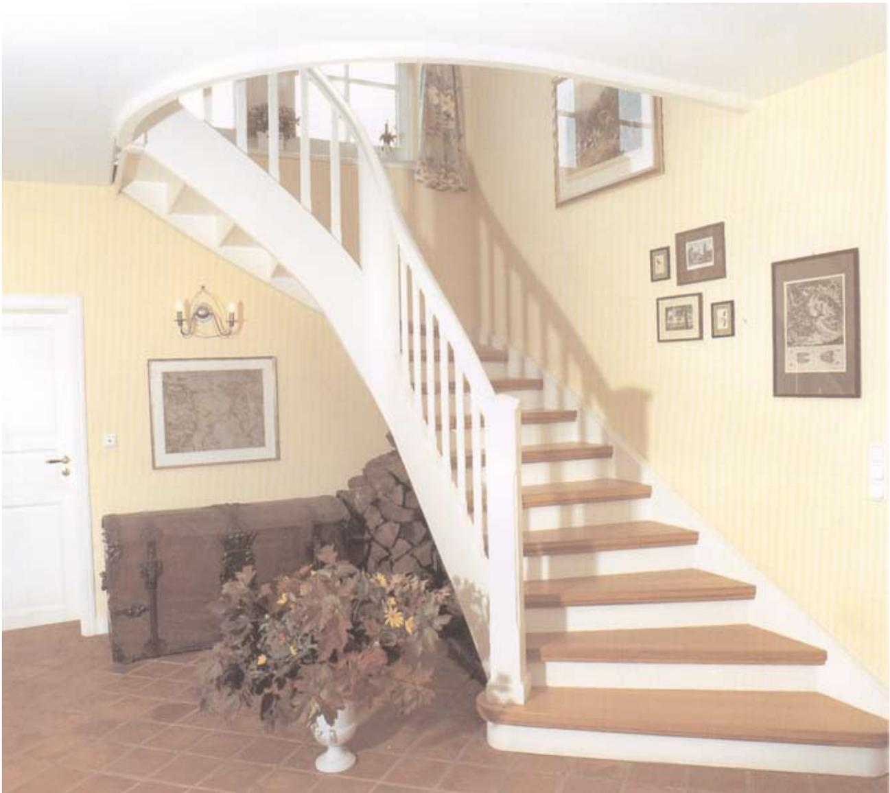
Deckend weiß lackiert mit Eichenstufen. Das aufwändige Geländer besteht aus einem Krümlingspfosten und Rechteckstäben mit Hohlkehle
